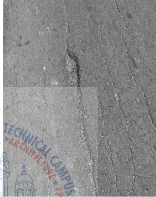
Fig 3.4: Longitudinal Cracking
